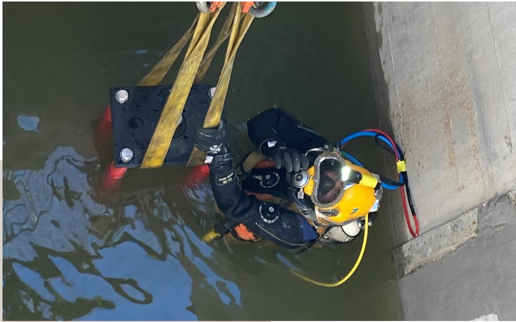
Unterwassermontage des Plattenschiebers DN 1200 – vorerst ohne Antrieb
