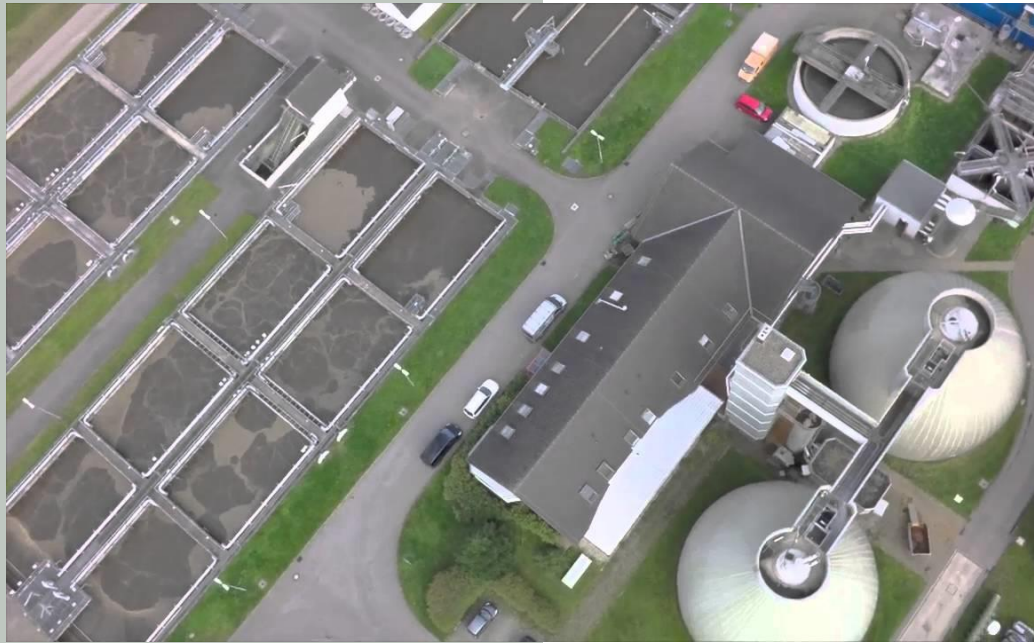
Die Gemeinschaftskläranlage (GKA) Baden-Baden•Sinzheim Foto: Stadt Baden-Baden
