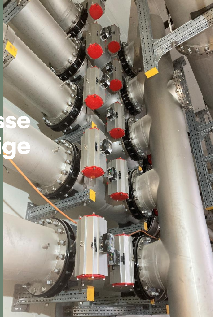
Pneumatisch betriebene Wey Absperrklappen TF20 DN 400
